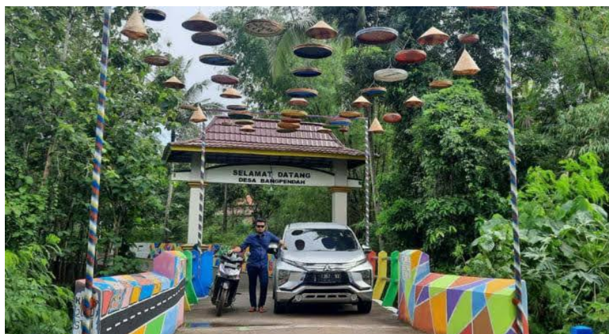
Jembatan Desa sesudah di revitalisasi
