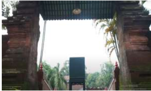
Gambar 10. Bentuk Gapura Candi Bentar sebagai pintu masuk Masjid Mantingan Sumber gambar: Dokumentasi pribadi
